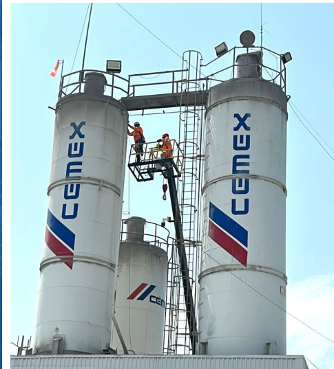
Limpeza de silo CEMEX
